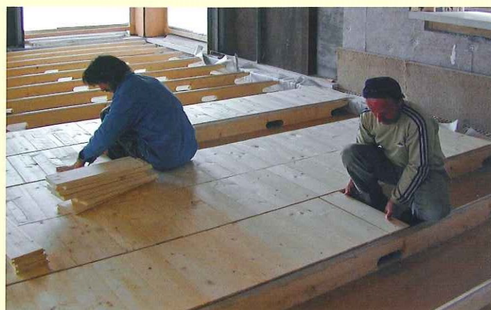
Posa dell'assito tecnico a chiusura del vano impianti.
