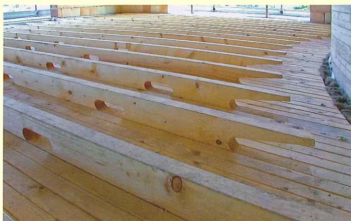
Solaio con vano tecnico e asole di testa su lato curvo.
