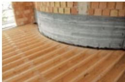
solaio curvo con vano tecnico
