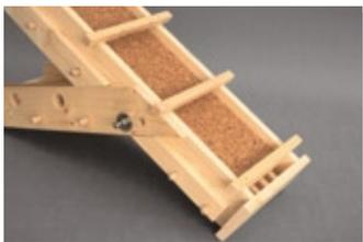
raccordo falda tetto e solaio
