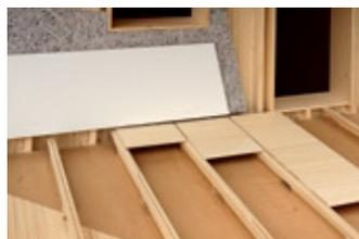
sezione della parete, con pannello interno in lana di legno + intonaco/gesso/piastrelle/legno ecc. e solaio interpiano con vano e assito tecnico.
