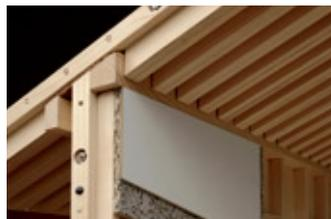
sezione copertura con incastro e collegamento alla parete irrigidita tramite una trave di banchina sagomata
