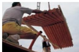
moduli tettoia incastrati a pettine e fissati a secco
