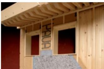
sezione della parete con imbotte dei fori finestra, pacchetto isolante esterno, intradosso di copertura a “Villa”, cornice sagomata, fori ventilazione.
