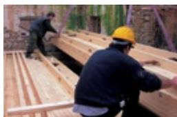
moduli solaio luce 8 m. portata 600 kg/mq.
