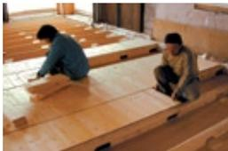
solaio controterra con vano e assito tecnico
