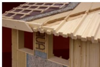
falda tetto con vano tecnico strati di coibente + guaina traspirante + doppio listello per la ventilazione del tetto.
