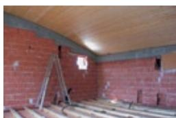
solaio curvo di copertura con moduli da cm. 50
