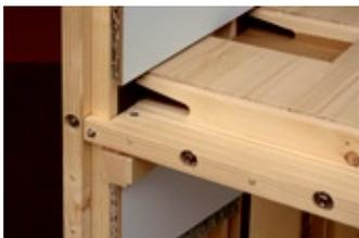
sezione del solaio interpiano con vano tecnico per impianti e collegamento a parete tramite banchina in legno
