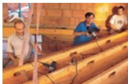
moduli solaio montati con orditura inclinata a 45°
