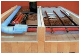
solaio con vano tecnico e costoloni con separatori
