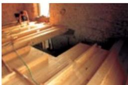
solaio autoportante con foro scala
